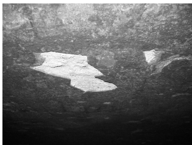
〈그림 1〉 진파리 4호분 연도동벽의 박리현상 〈그림 2〉 진파리 4호분 연도서벽의 박리현상
