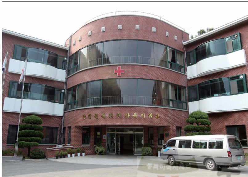
▲ 경남 합천군 합천읍 영창리 439번지 합천원폭피해자 복지회관 전경 (중앙일보, 2010. 8. 12)
