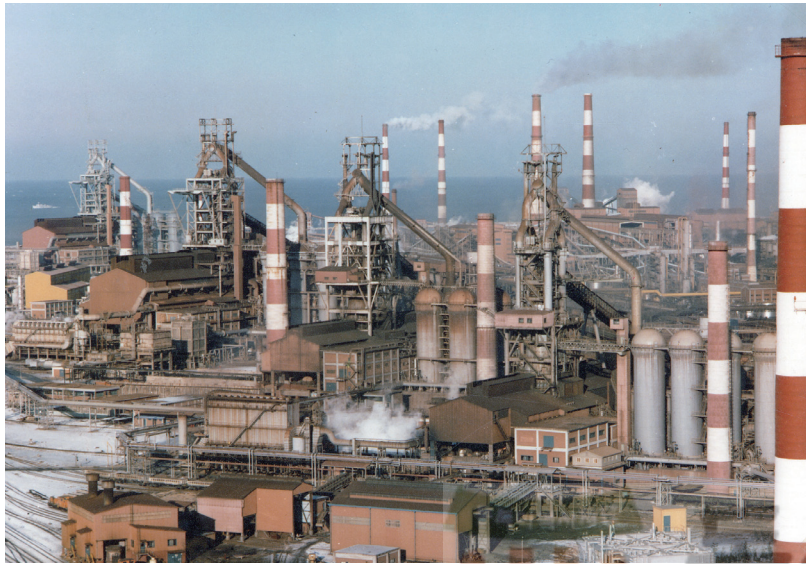
▲ 세계 6위의 철강생산국으로 끌어올리는 데 결정적 역할을 한 포항제철의 포항 제철소 전경. 포항제철 건설에는 유상·무상의 청구권자금 약 1억 3천만 달러가 투입되었다. 일본의 미쓰비시, 미쓰비시 등이 공사에 참여하고, 신일본제철 등이 기술을 제공했다. (중앙일보, 1997. 4. 14)
