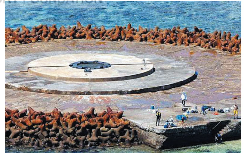
<그림 5> 콘크리트로 보강한 오키노도리시마 출처: www.japanfocus.org
